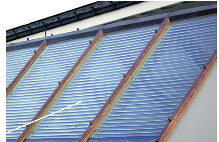
Fixierte Anordnung im Scheibenzwischenraum, wartungsfrei und funktionssicher
