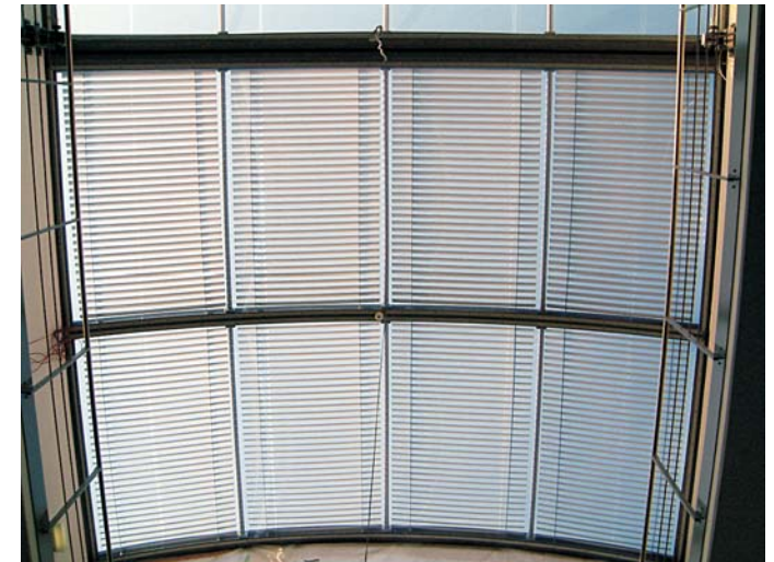
Innenhofüberdachung GFMI, München-Riem
